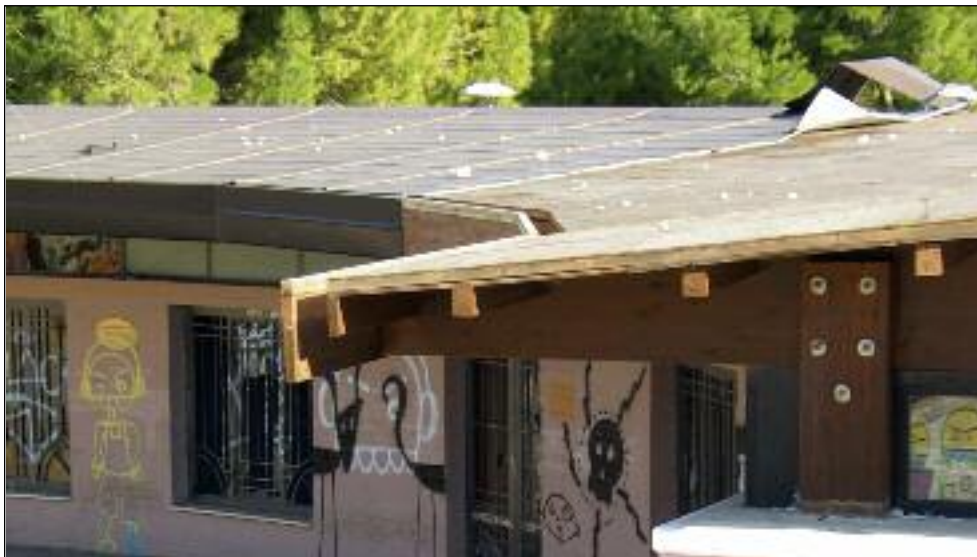
La copertura in lastre metalliche del centro polivalente è stata rimossa. Chissà per farne cosa...
