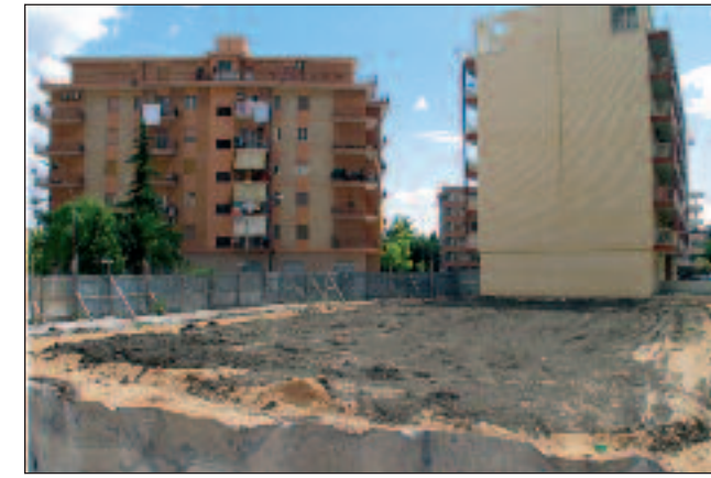
L'area del crollo di viale Giotto
