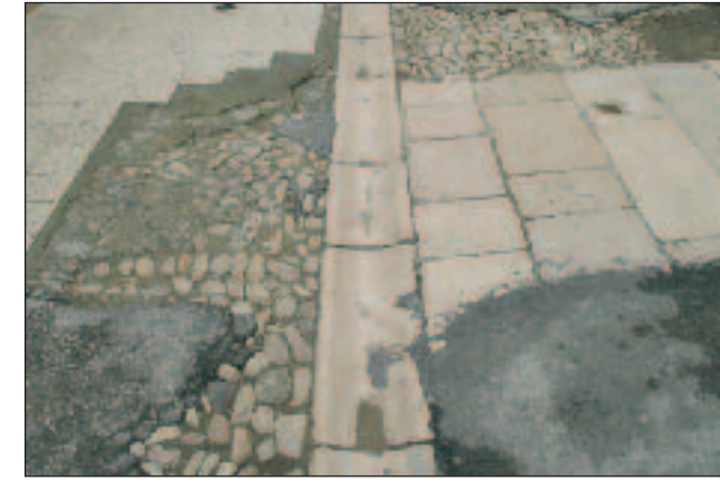
Pavimentazione storica in via Molignano
