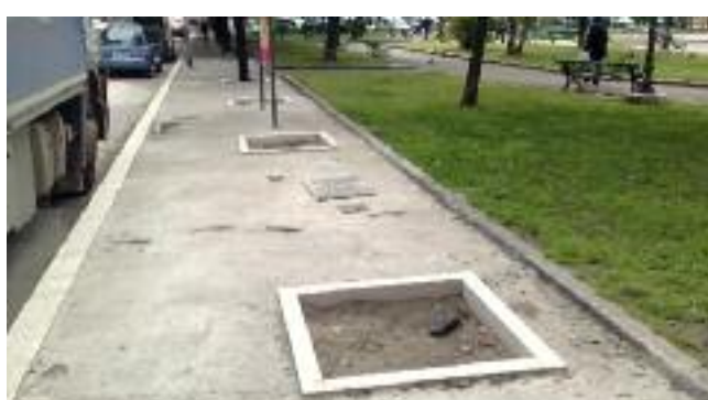
Piazza M. Barone - lavori in corso per i marciapiedi. Ci auguriamo che sia stato previsto di piantare tutti gli alberi che mancano ormai da tempo. Più di 10 aiuole sono state realizzate per accogliere ognuna un fusto.
