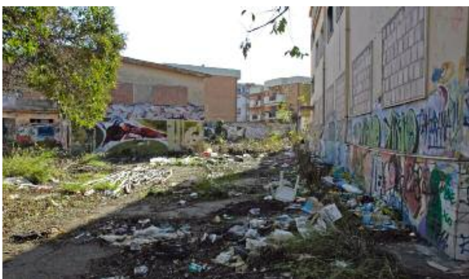
Siamo al Martucci e chunque ha libero accesso ad una struttura fatiscente e pericolosa
